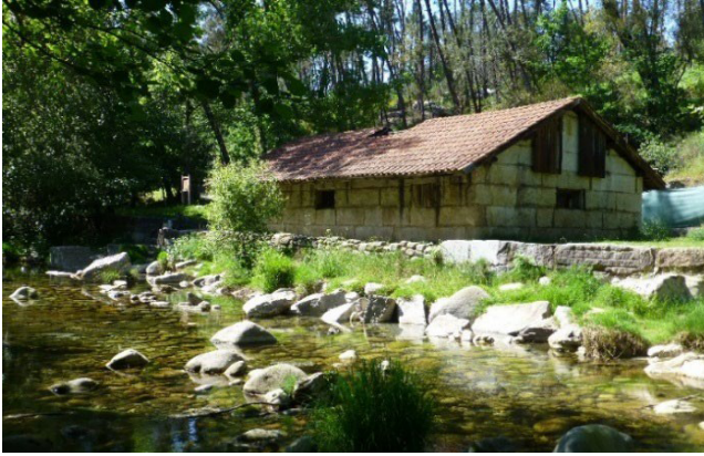
Fig. 16 Antigua casa de baños Fuente: Ourense natural
