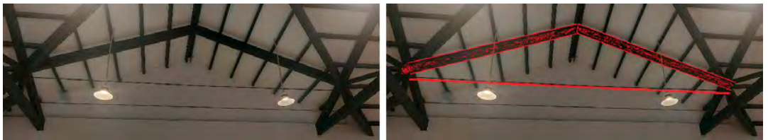
Figura A-1.2 Exemplo de celosía simple de cuberta.
