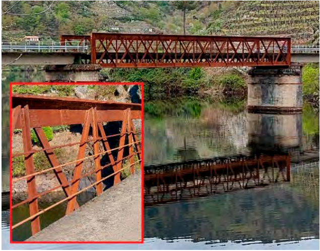
Figura A-17.6 a) Foto de celosía con ariostamentos hiperestáticos de unha ponte de aceiro.
