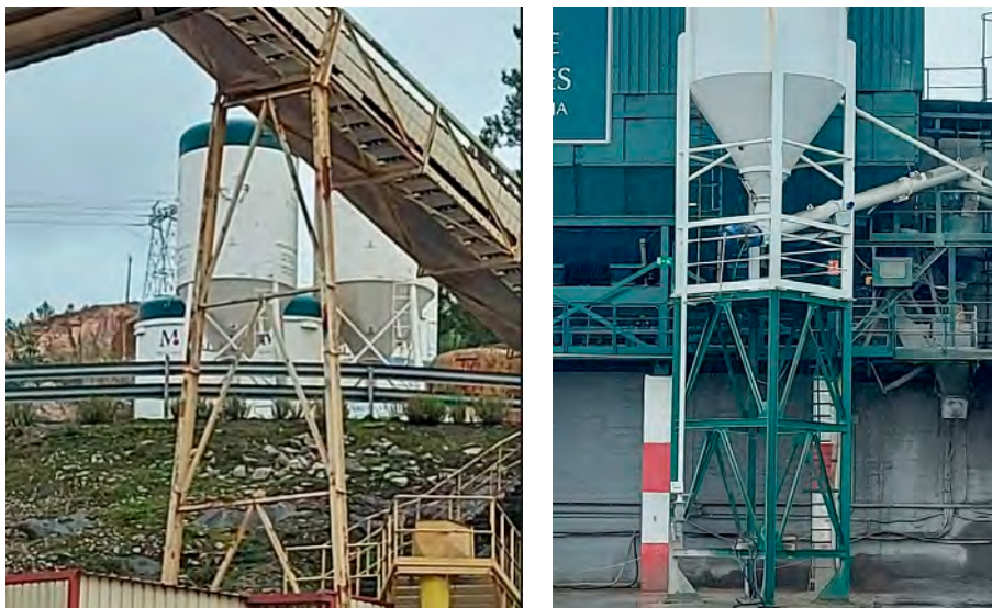
Figura A-13.6 Exemplos de aplicación de arriostramentos en V en dúas estruturas. O apoio dunha cinta transportadora. A base dun silo.
