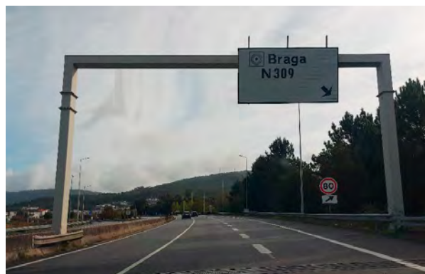
Figura 2-34. Exemplo real de pórtico de 3 barras
