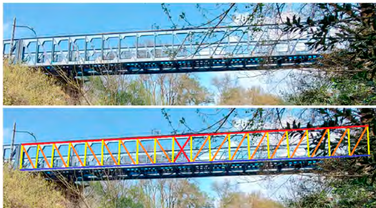
Figura A-8.5. Figura onde se pode observar unha celosía dunha ponte ferroviaria ca mesma disposición ca calculada.
