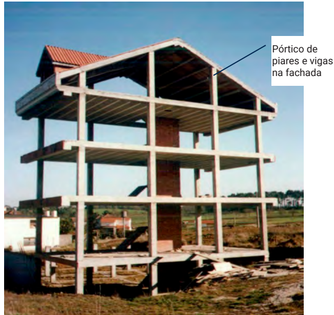
Figura 2-3. Exemplo de estrutura de nodos ríxidos, formada por dous pórticos principais, con forxado entrambos
