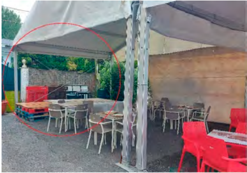
Figura A-16.3. Nesta figura podemos observar no lado esquerdo o esquema de funcionamento dos arriostramentos dos dous cabos, no lado dereito unha foto da aplicación desta solución entre os dous pilares nos pórticos de dunha carpa para así darlle estabilidade e rixidez no plano en que esta situados os cabos.
