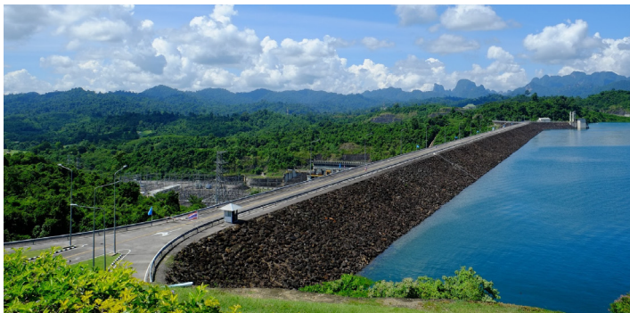
Figura 5.12: Detalle de una presa de materiales incoherentes.
