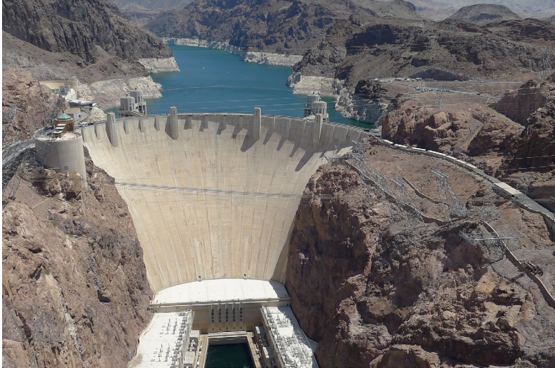
Figura 5.14: Detalle de la presa de arco-gravedad en la central Hoover, río Colorado, EEUU.
