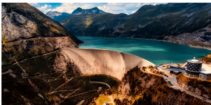
Figura 5.9: Detalle de una presa de arco.
