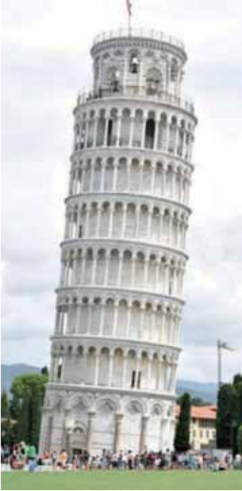
Figura 3: Torre inclinada de Pisa construida principalmente con mármol de San Giuliano, la Toscana, Italia. Construcción 1173-1370.
