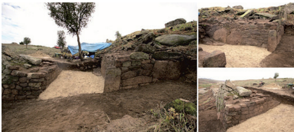
Fig. 17. Vista xeral da Sondaxe 2 unha vez finalizada a intervención.
