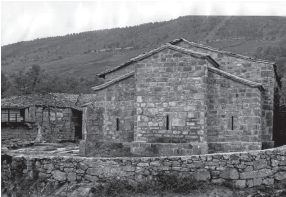
Fig. 4. Fachada prerrománica leste da igrexa de Sta. M a de Mixós, Monterrei (Fot. AHP O , anos 50-60).
