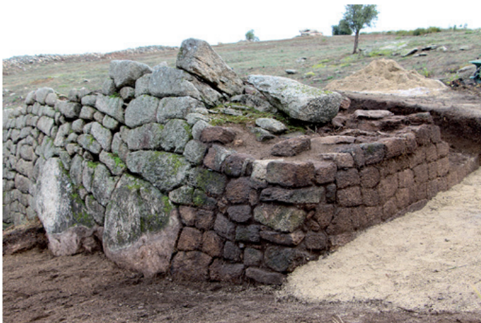
Fig. 18. Lenzo norte da muralla, no que se pode observar na parte externa o muro poligonal/ciclópeo, mentres a cara interna da porta se constrúe nun aparello similar ao opus quadratum .
