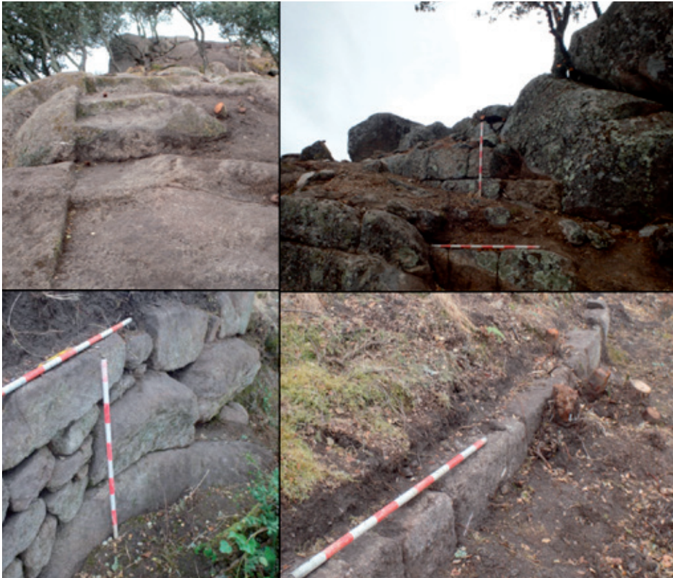
Fig. 5. Distintas solucións empregadas para a construción da muralla do castelo de Lobarzán.
