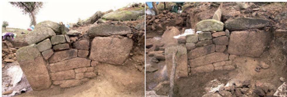
Fig. 14. Estado da zona oeste da porta, antes e o despois do proceso de recolocación de pedras para o conxunto da xamba.
