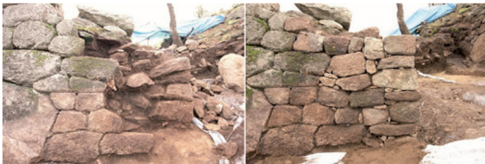
Fig. 16. Fotografía previa e posterior a intervención no esquinaleste.
