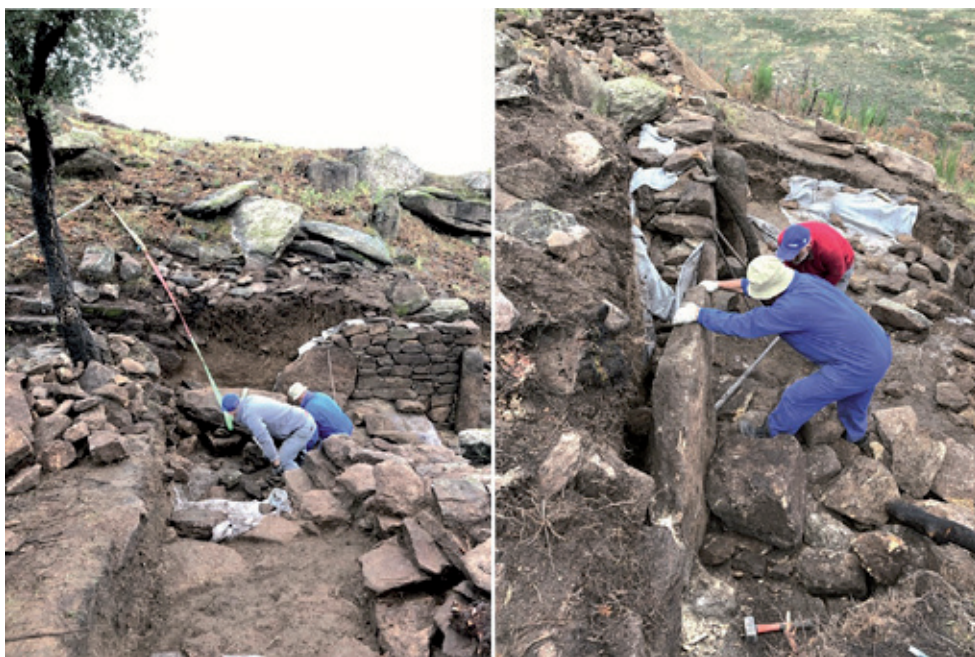
Fig. 15. Proceso de colocación da pedra de maior tamaño do muro.
