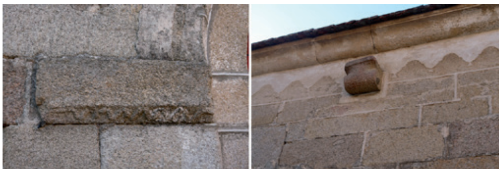
Fig. 6.. Detalles da capela da Cruz en Vilaza, Monterrei (Foto: N. Amado).
