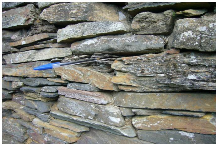
Figura 4.27. Exfoliaciones en rocas metamórficas de los muros del Castro de Viladonga.
