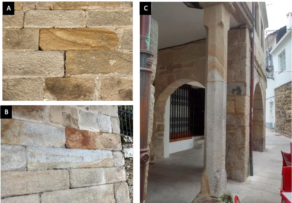
Figura 4.10. Bandas pardo-amarillentas en sillares de las fachadas de las iglesias de Sta. María do Campo (Muros, 2023, A) y San Pedro de Muros (B); en C, aspecto de una columna de granito con aureolas de oxidación en el casco histórico de Muros.
