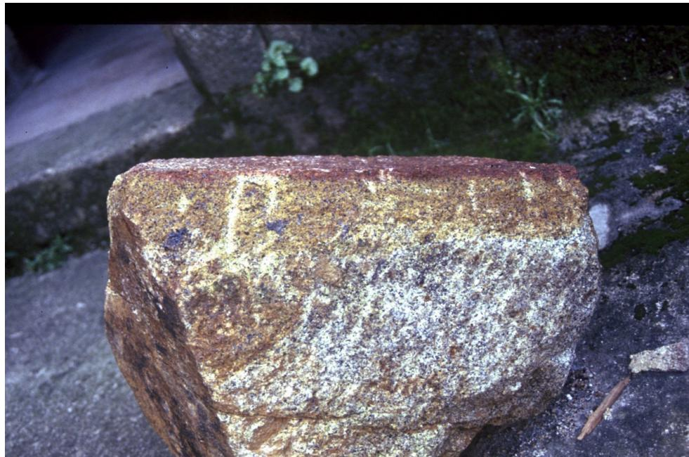
Figura 4.7. Sillar retirado del muro de la iglesia de San Marcos (Corcubión) mostrando su superficie enrojecida y tonalidades más pardas hacia el interior del sillar probablemente ocasionadas por el gran incendio ocurrido en el S. XVIII.
