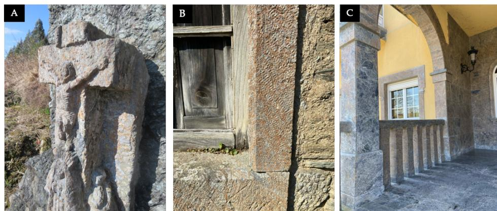
Figura 2.7. Algunas rocas serpentinizadas usadas en monumentos y edificaciones. A: cruceiro-peto de ánimas en la localidad de As Somozas (A Coruña); B: marco de las ventanas de una casa antigua aledaña al Castelo de Moeche (A Coruña); C: pórtico de acceso del edificio del Concello de Moeche, construido con serpentinita de la zona.
