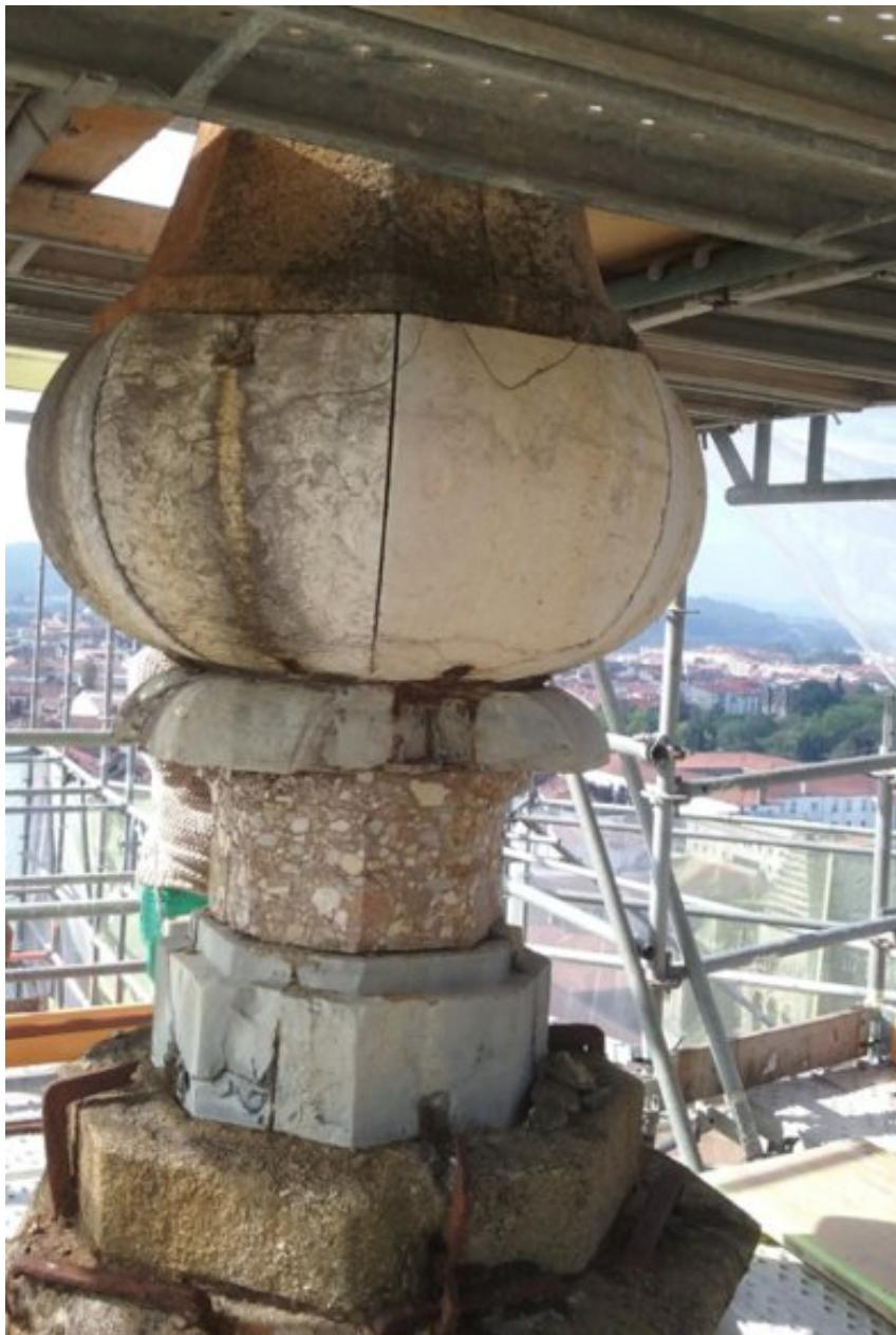
Figura 1.22. Pináculo en la Catedral de Santiago de Compostela en el que se aprecia el uso de diferentes rocas: granito, mármol y conglomerado.
