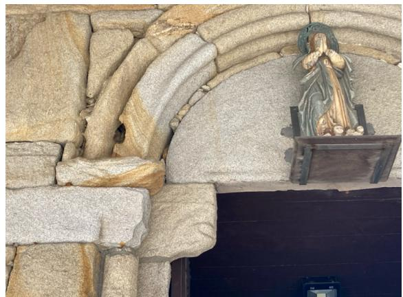
Figura 4.18. Redondeamiento de aristas causado por la pérdida de masa debida a arenización. (Izquierda: Santa María de Fisterra, 2017; derecha: Santa María do Campo (Muros, 2023)).
