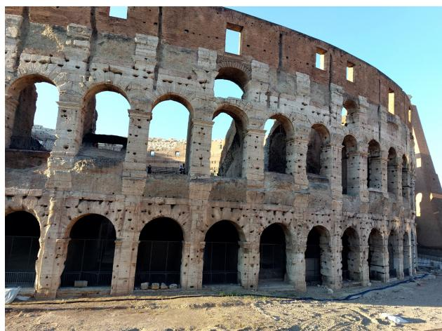
Figura 1.16. Travertino empleado en el Coliseo romano (Cortesía de C. Genona).
