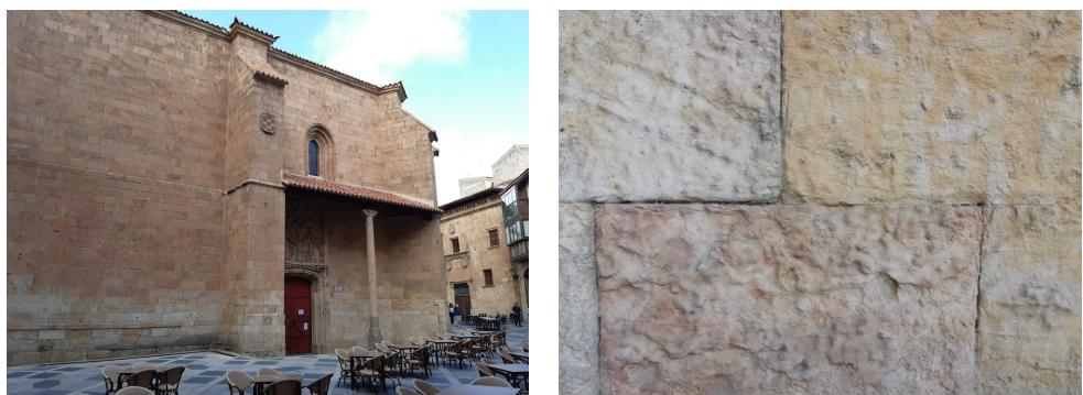
Figura 1.19. uso de la arenisca de Villamayor como material constructivo: Iglesia de San Benito en Salamanca, y detalle de la sillería.
