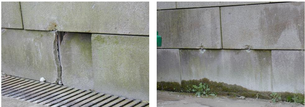
Figura 6.12. Rotura de las piezas de granito empleadas en el Centro Galego de Arte Contemporánea por los puntos de anclaje (1996).
