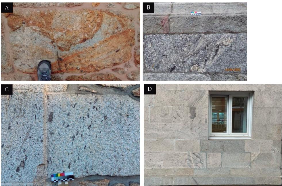
Figura 2.9. Sillería hecha con migmatitas (resultado de procesos de anatexia) de diferentes texturas, en edificios de diferentes localidades. A) casa antigua en Camelle (A Coruña); B: Iglesia de Santiago de Cangas (Pontevedra); C: casa antigua en O Rosal (Pontevedra); D: fachada del edificio de la Cruz Roja, en Vigo (Pontevedra). En todas las imágenes se aprecian los bandeados oscuros (paleosoma) de mayor o menor envergadura.
