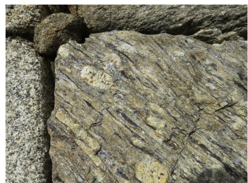
Figura 2.4. Imágenes de una sillería mixta hecha con granito y gneis *Ollo de Sapo* (Celeiros, Ribeira Sacra). Destacan los blastos de cuarzo azul oscuro y los blastos de feldespato potásico, de color crema.
