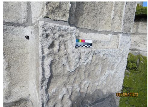
Figura 4.21. Alveolización en sillares de granito de diferentes estructuras de la torre del Convento de Santo Domingo (A Coruña) (2023).
