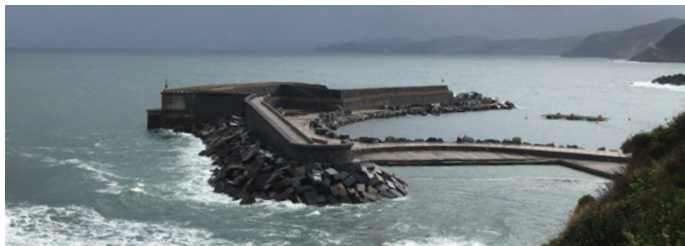
Figura 5.9. Planta de enerxía de Mutriku (Euskadi)
