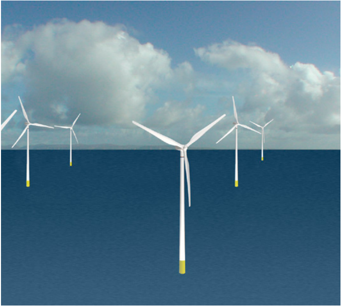
Figura 3.4. Esquema dunha turbina de tres pas dispostas en horizontal. Imaxe obtida de Aqua-RET ( www.aquaret.com )
